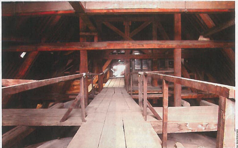
Charpente et chemin sous le toit de Notre-Dame de Paris
